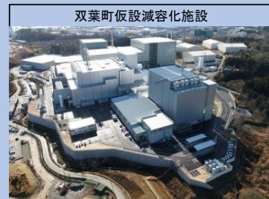
双葉町等で発生した除染廃棄物や災害廃棄物等を減容化する施設。2020年3月より処理開始。
