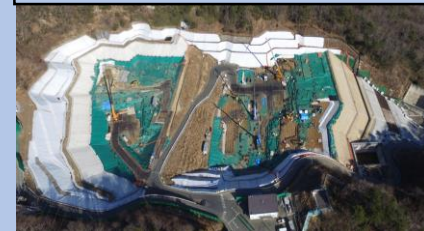
特定廃棄物埋立処分施設 (旧フクシマエコテッククリーンセンター)
