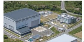
檜葉遠隔技術開発センター
