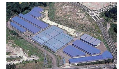
レアメタル国家備蓄倉庫
