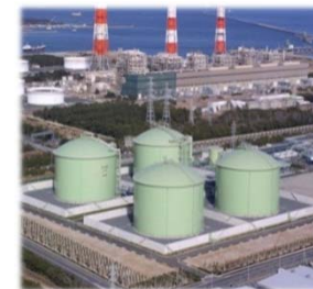
神栖国家石油ガス備蓄基地
