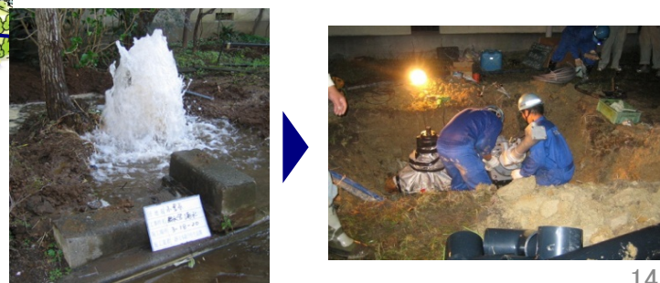
屋外給水管漏水
