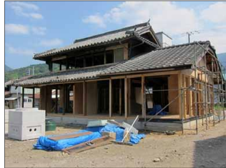
改修工事が進むプラットイーズ
