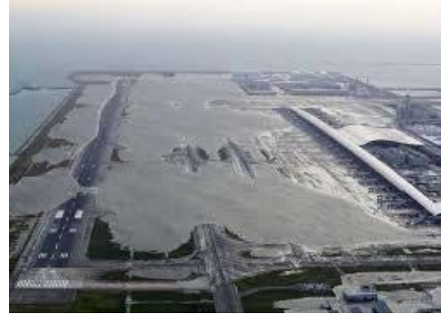
平成30年台風第21号による関西国際空港の被害状況
