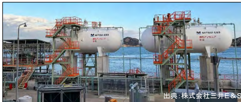
陸上試験用アンモニア燃料タンク・燃料供給システム※
