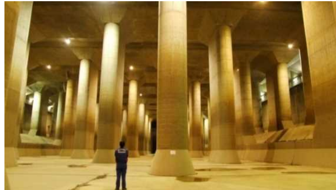
高さ18m、幅78m奥行き177mの巨大な“地下神殿”調圧水槽
