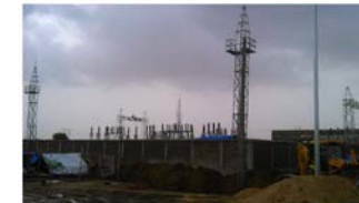
マンダール工業団地内で建設が進む変電所 (JETRO資料)
