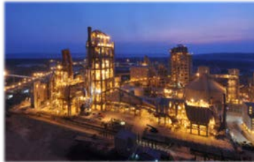
図表10 インドネシア セメント廃熱回収発電
