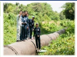
水道分野の専門家による送水管の敷設状況の現場指導に基づく開発途上国の水道支援 出典：JICA
