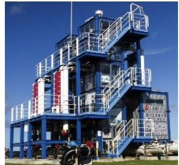
島嶼国等への展開が期待される海洋温度差発電（沖縄県久米島の実証設備）
