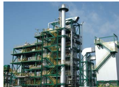
木質バイオマス発電施設
