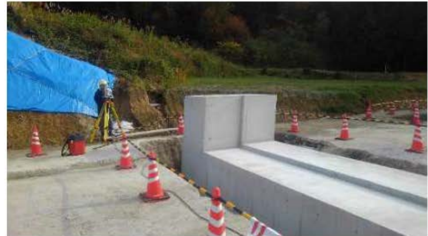
【地上レーザースキャナー搭載型 TS による点群取得状況】
