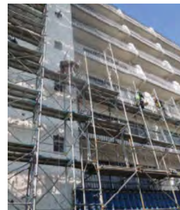
&lt;仮設足場&gt;
