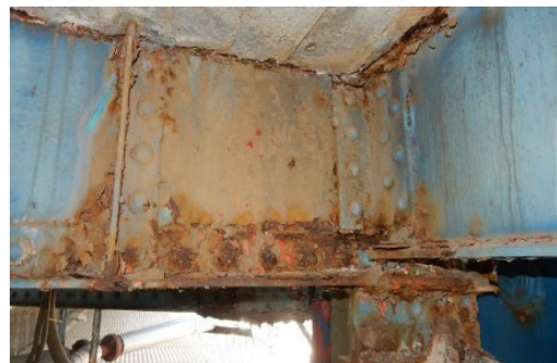
主桁の腐食
