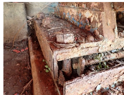
支承の腐食、アンカーボルトの欠損
