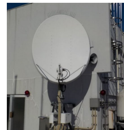
衛星通信アンテナ(白石市庁舎)
