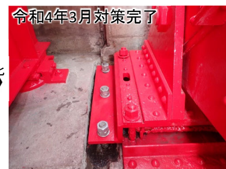
再塗装、アンカーボルトの設置
