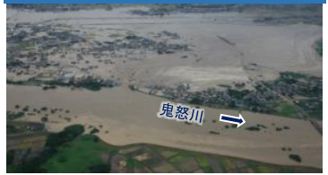
①鬼怒川の堤防決壊による浸水被害 (茨城県常総市)
