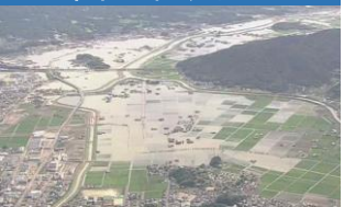
⑫六角川周辺における浸水被害状況 (佐賀県武雄市)
