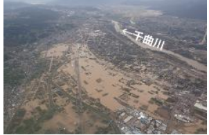
⑨千曲川における浸水被害状況 (長野県長野市)
