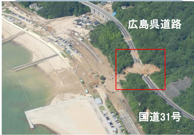
平成30年7月豪雨における 広島呉道路の被災状況
