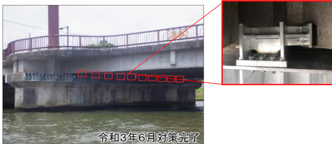
吾妻橋（石川県珠洲市）の耐震対策
