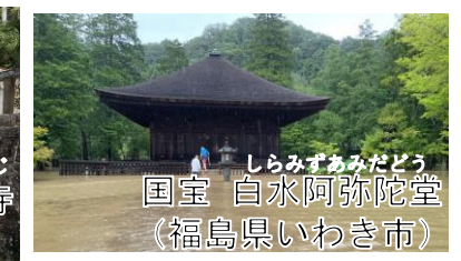
【被災例】台風第13号で床上20cmまで浸水 土砂撤去や被害を受けた部材の早急な復旧、及び設備の嵩上げ等の対策を行う
