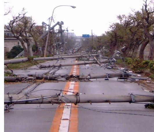
電柱の倒壊による道路閉塞
