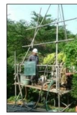
【ボーリング調査】
