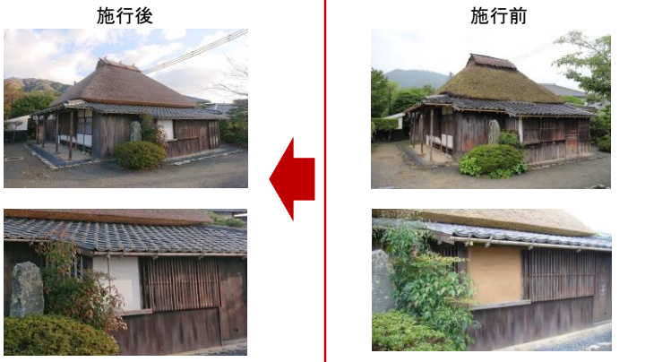
老朽化対策工事（史跡 伊藤博文旧宅）
