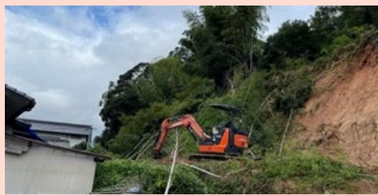
だざいふあと 特別史跡 大宰府跡（福岡県） 梅雨前線による大雨で、崖が崩壊、住宅に土砂が流入
