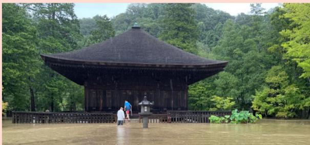
しらみずあみだどう 国宝 白水阿弥陀堂（福島県） 台風13号で床上浸水、泥が堆積、防災設備に深刻な被害
