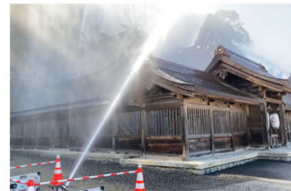
【対策後】最新の自動放水銃の整備、鉄筋ブレースでの耐震補強
