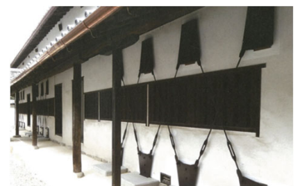
【対策後】最新の自動放水銃の整備、鉄筋ブレースでの耐震補強
