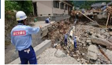
TEC-FORCEによる被災状況調査
