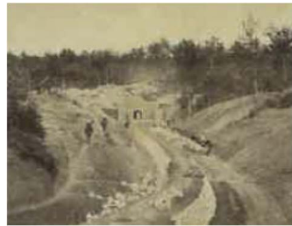
明治時代に開削された隧道 [兵庫県: 淡山疏水]
