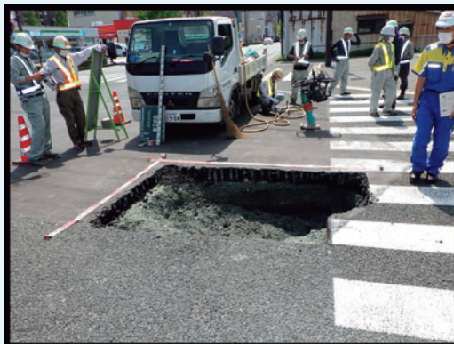
写真 1-2-13 老朽化に起因する下水道管の破損による道路陥没事故（令和 2 年）の様子
