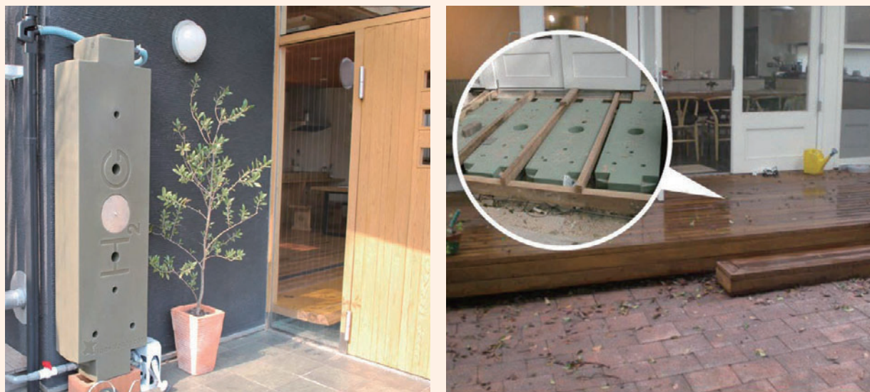
写真 特28 個人住宅での雨水貯留施設の設置例（左：壁面設置 右：軒下設置）
