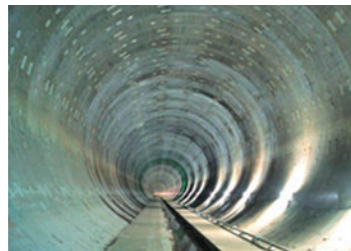
和田弥生幹線 (貯留管:直径8.5m、延長2.2km)
