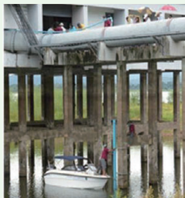
写真2-8-7 バンプラ湖への水位計測機器の機材設置状況（タイ）
