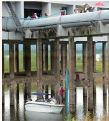
②モーター舟上での保護管のフレームへの建て込み
