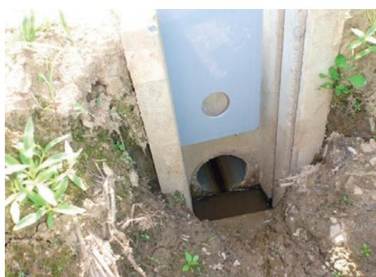
写真：調整板の設置例
