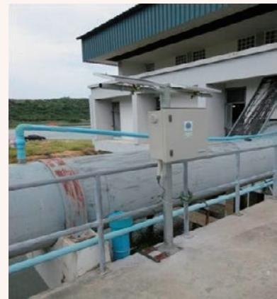
③コントロールボックス、ソーラーパネル、水質センサの設置及び固定の完了
