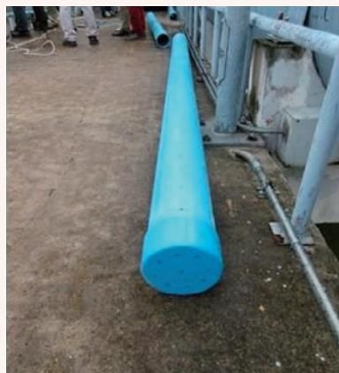
①水質センサを設置する保護管（D150 硬質ポリ塩化ビニル管）の底に蓋をし、穴開け
