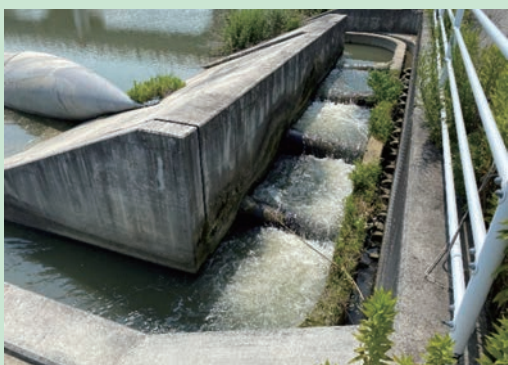
環境との調和に配慮した水路 （「岡山南部地区」の魚道）
