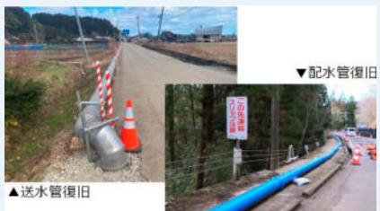
令和6年能登半島地震の被災地では、応急復旧の迅速化のため、仮設配管の活用や上下水道一体での復旧を実施
