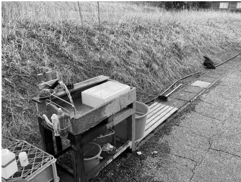
図4- 2 地すべり対策水抜孔から配管を敷設し、生活用水に活用した例（石川県珠洲市）
