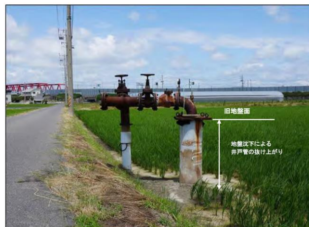
図 7.2 実際の地盤沈下被害
