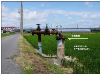
写真-1 三重県桑名郡水戸町の水戸の抜け上がり状況（平成26年6月撮影） ※ 近隣の水準点(C45-90)における累積沈下量：117cm(昭和36年～平成27年) 出典：平成27年における濃尾平野の地盤沈下（東海三県地盤沈下調査会、2016）
