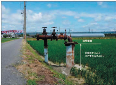
写真-1 三重県桑名郡木曽町町の井戸の上げ上がり状況（平成26年4月撮影） ※ 近傍の水車道(C35-09)における累積沈下量：11.7cm(昭和38年～平成27年) 出典：平成27年における濃尾平野の地盤沈下（東海三県地盤沈下調査会、2016）
