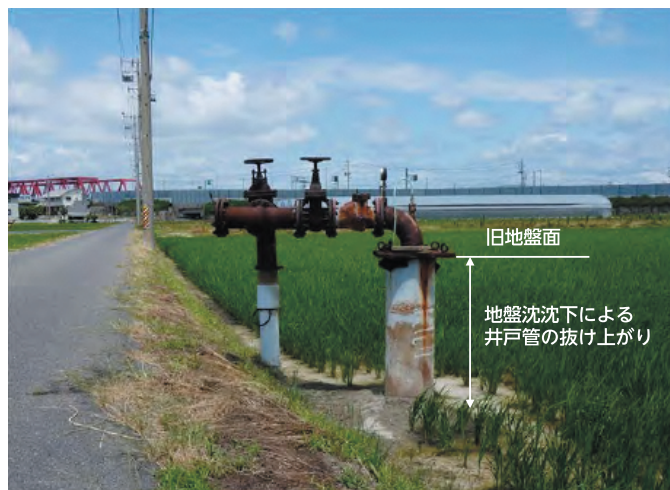
図 7.2 実際の地盤沈下被害
