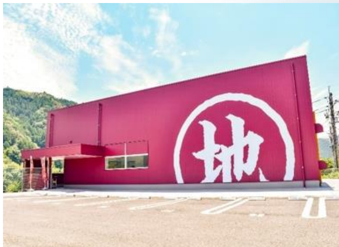
高知県版HACCPを取得した工場
