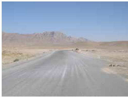
完成後(2004年9月完工)
