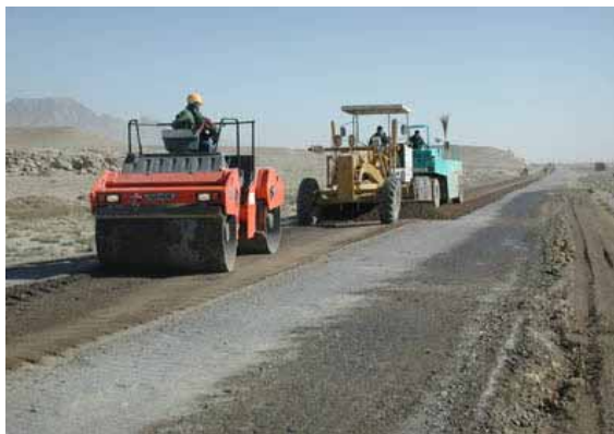
舗装工事の様子
