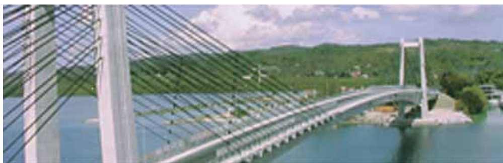
完成した日本パラオ友好橋
