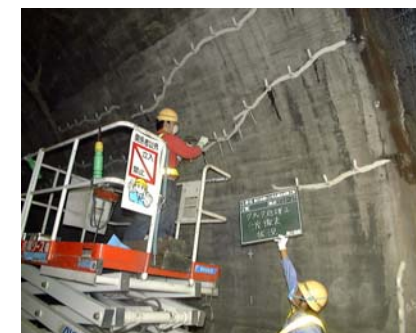
ひび割れの補修
