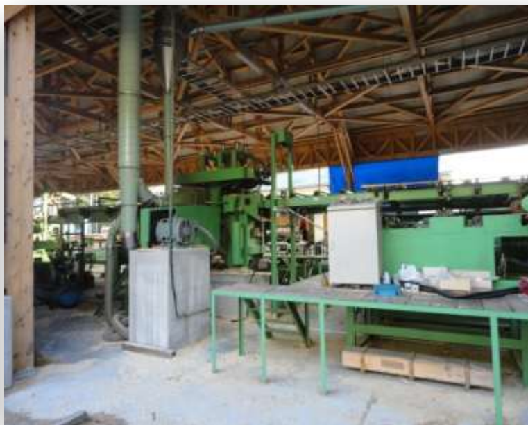
共同製材工場施設
