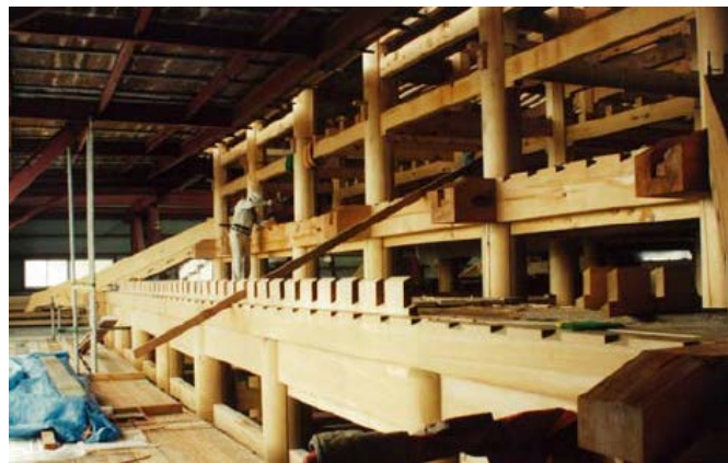
木工事の状況
