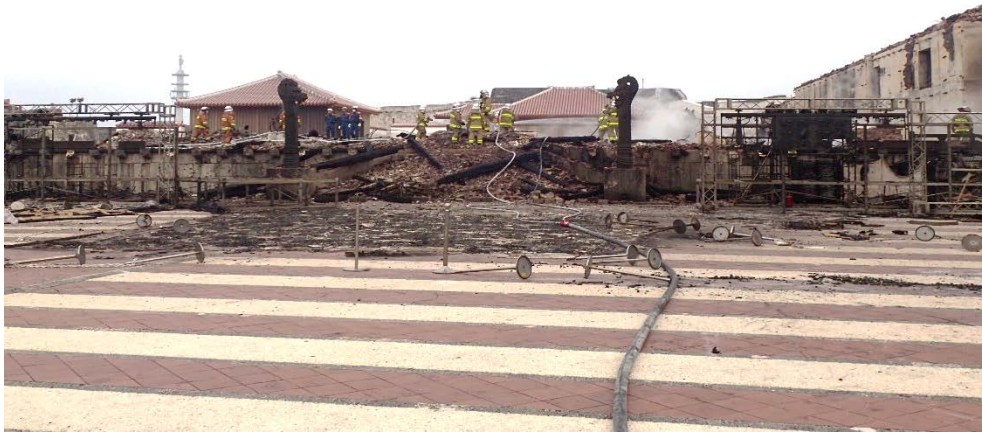
①正殿（建物西側から撮影）（全焼）
