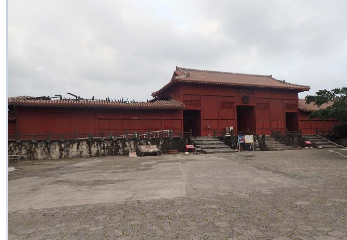
⑦奉神門（建物東側から撮影）（半焼）
