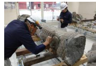
◀大龍柱補修作業の公開
