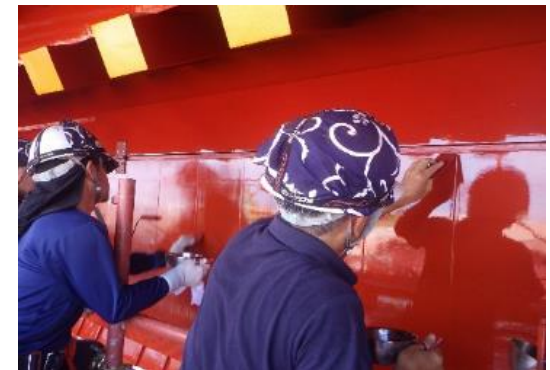
正殿の外壁塗替え(H30年度)
