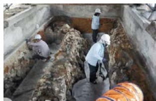
◀正殿遺構の保護処置
