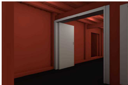
防煙区画への防火戸の設置
