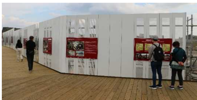
正殿復元工事の見学用デッキ
