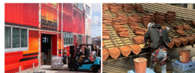
県産赤瓦の正殿搬入状況及び瓦葺き状況
