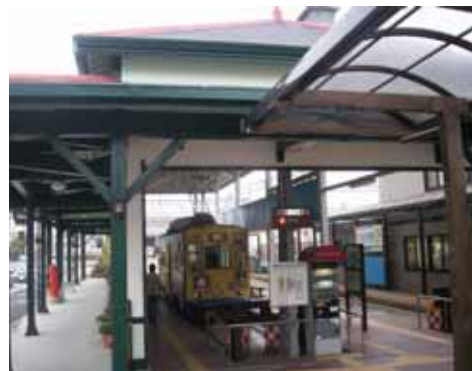
写真 11: 市電停車場内部
