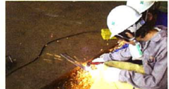
工場での溶接作業
