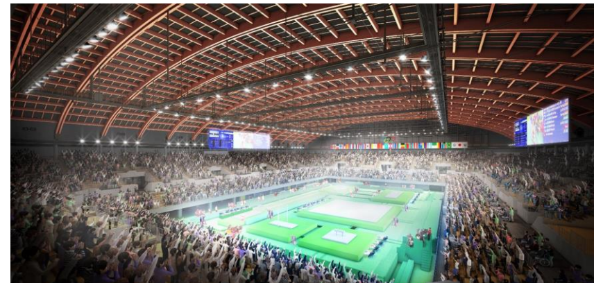
国産木材を使用した屋根架構
