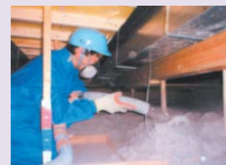
天井の断熱改修
